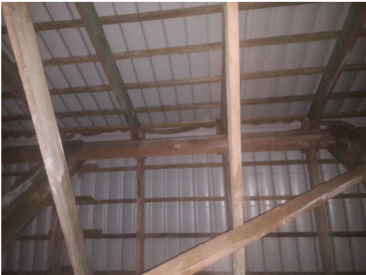
Уплотнитель между коньком и металлочерепицей выдавило ветром
